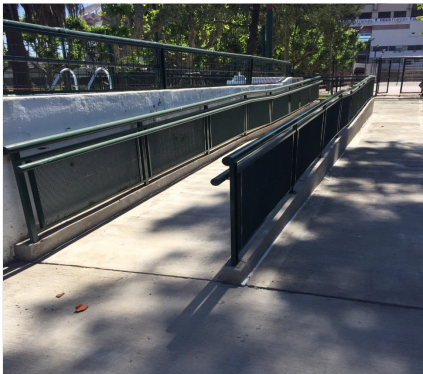
Nueva rampa para discapacitados en pileta T
