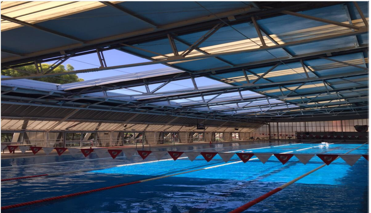
Reacondicionamiento paneles de apertura de techo en pileta cubierta
